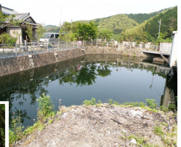
『貯水池』 豊かできれいな四万十川を守るため、養殖池で使った水は、一旦貯水池で沈殿濾過して、浄化してから川に排水しています。
